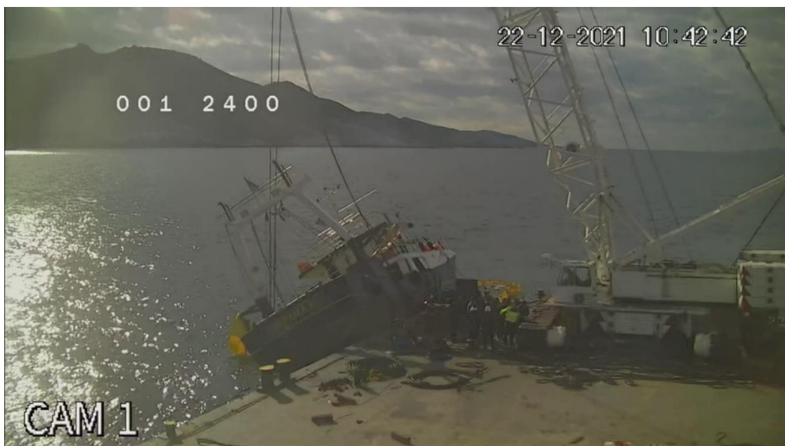
Εικόνα 14: Εξελισσόμενες εργασίες ναυαγιάρεσης του «OYRANIA A»
